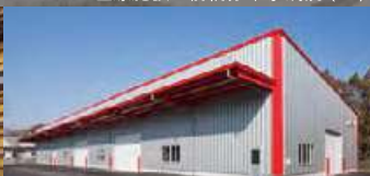
工場・倉庫 O 社倉庫
